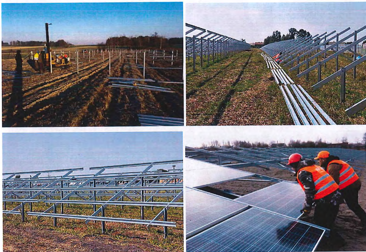
Rysunek 29. Budowa i montaż instalacji fotowoltaicznej
