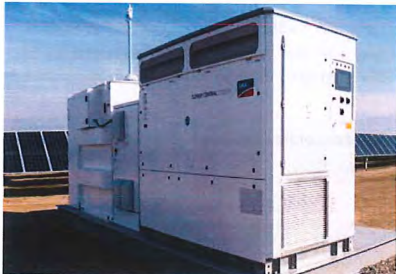
Rysunek 26. Inwerter w postaci centralnej (z lewej) oraz w systemie rozproszonym (z prawej)
