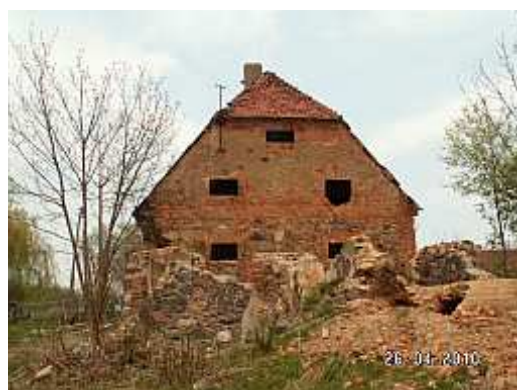
[4] – wolarnia w rozbiórce
