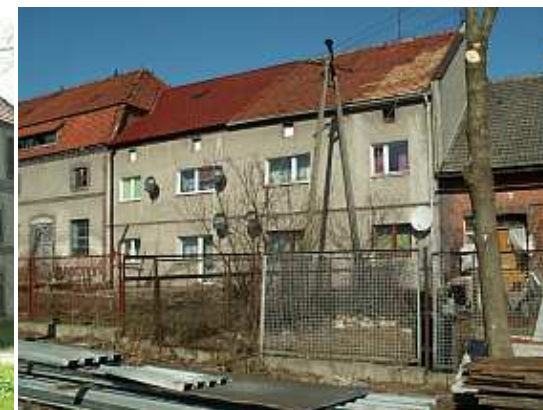
[9]- stajnia- ob. dom mieszkalny
