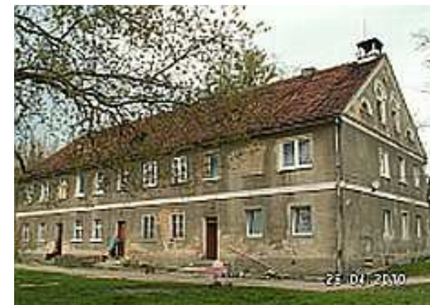
[3] poz. 6- dom mieszkalny (obecny nr 12A)
