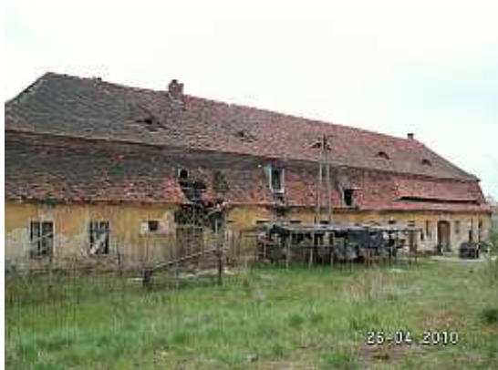
[2] obiekt wielofunkcyjny- Borów Wielki 57 B
